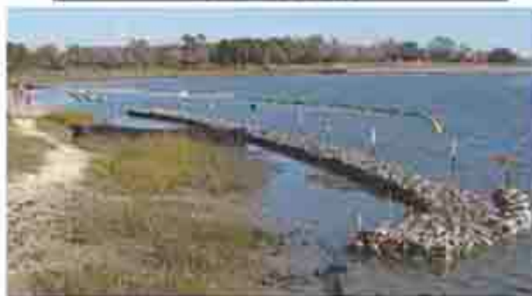
Construcción de un arrecife de ostras en Alabama (EEUU)
